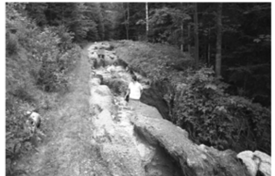
Unwetterschäden - Schadenserhebungen, Wiederherstellung von Wegen etc..
